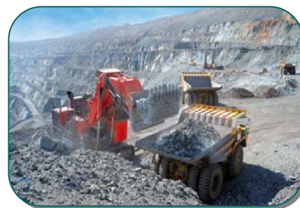
El BAFD ha financiado la creación de una planta de extracción de hierro
